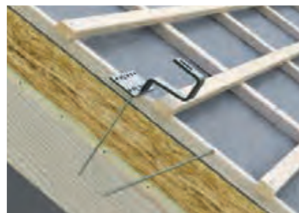
Montage de crochets de toit solaires
