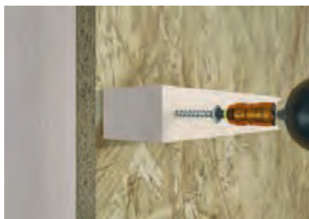
Fixation d'un niveau d'installation
