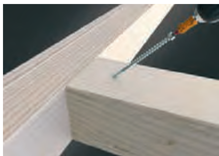
Assemblage poutre principale/secondaire
